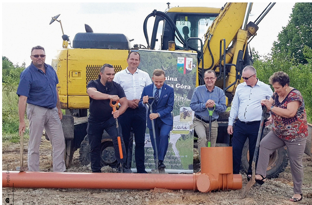
Rozpoczęcie piątego etapu budowy kanalizacji i przebudowy wodociągu w Porzeczu. Termin realizacji całego przedsięwzięcia przewidziano do dnia 31 sierpnia 2021
