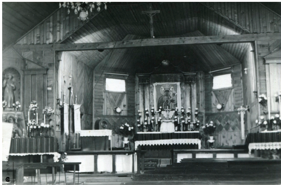
◀ Pierwszy kościół parafialny ▲ Wnętrze kościoła ▼ Obecna świątynia w trakcie budowy
