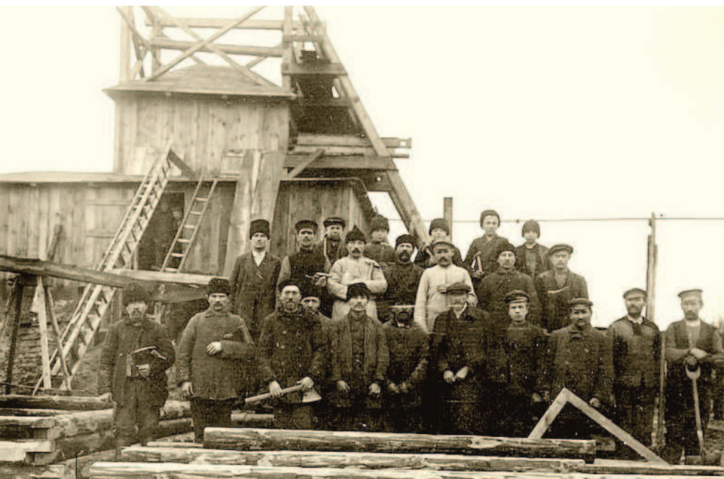
Budowa szybu „Austriackiego II” w 1916 roku (www.miedziana.pl)
