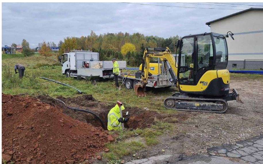
Prace przy wymianie starego wodociągu w sołectwie Ćmińsk Kościelny
