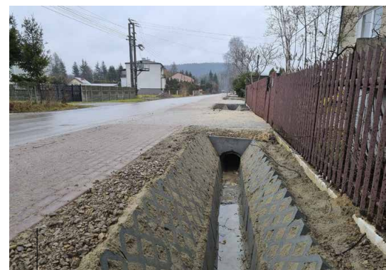
Wyremontowany rów na Wyrowcach
