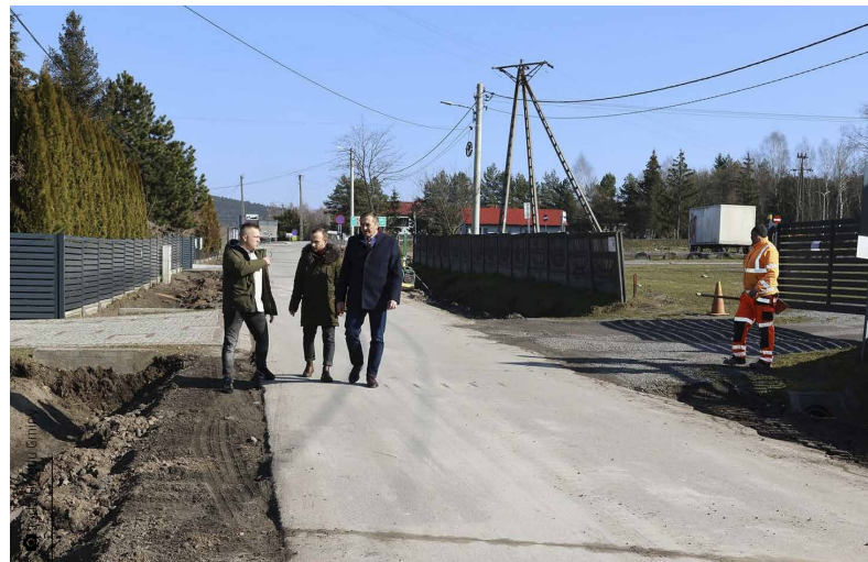
Przebudowa ulicy Wykień w Ćmińsku Kościelnym
