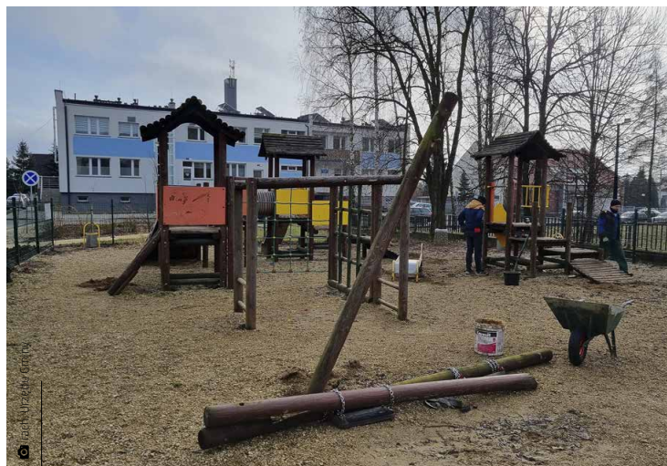
Prace przy przebudowie placu zabaw rozpoczęły się pod koniec lutego
