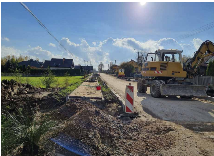
Przebudowa drogi powiatowej na odcinku Przyjmo-Bobrza
