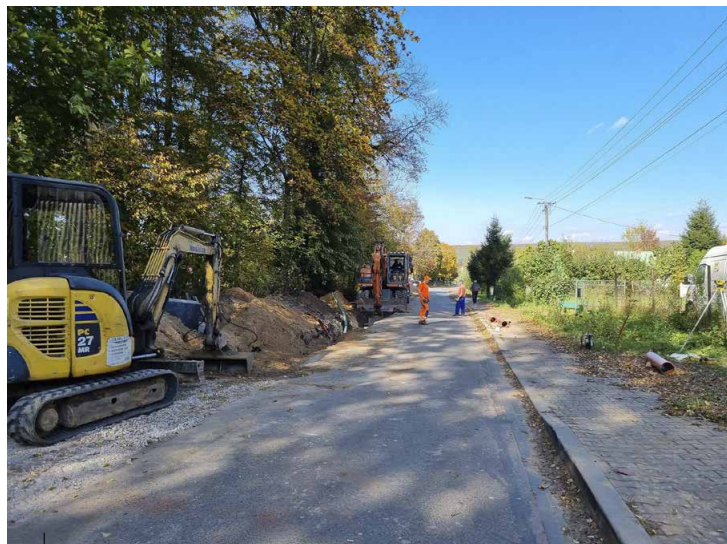
Budowa sieci kanalizacji sanitarnej w sołectwie Ćmińsk Rządowy
