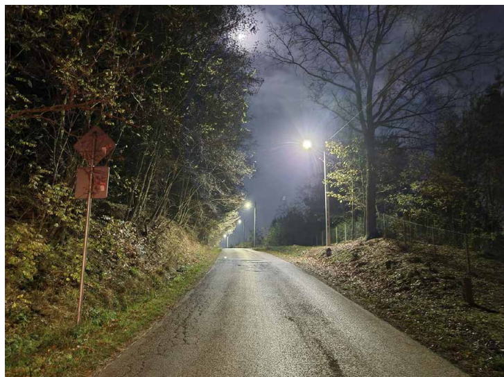
Kontynuacja budowy i modernizacji oświetlenia ulicznego na terenie gminy
