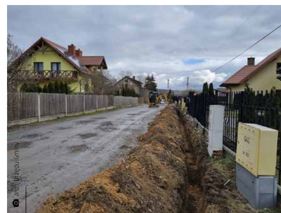
Budowa oświetlenia ulicznego na ulicy Działkowej w Kostomłotach Pierwszych
