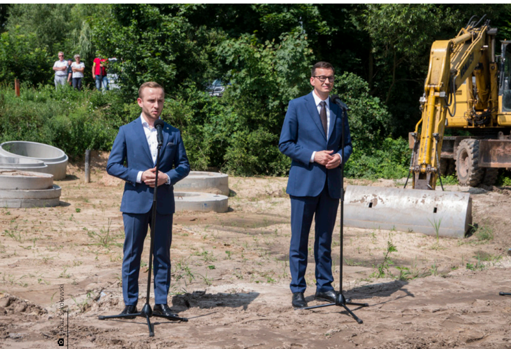
W lipcu gminę, a dokładnie plac budowy kanalizacji i przebudowy wodociągu w Porzeczcu odwiedził Premier Mateusz Morawiecki
