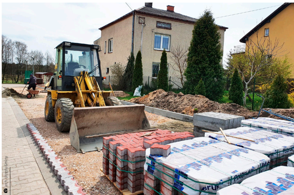
Prace budowlane przed Szkołą Podstawową w Porzeczu
