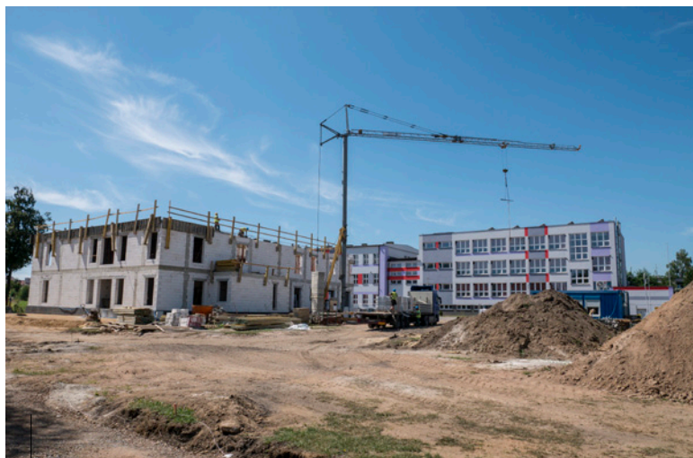
W sierpniu 2020 roku pracowaliśmy przy drugiej kondygnacji żłobka
