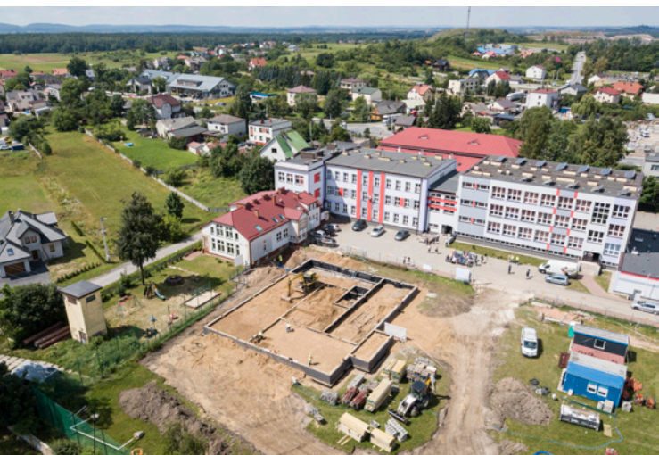
W lipcu 2020 roku postawiliśmy fundamenty żłobka
