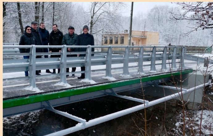
W ostatnim dniu listopada odbył się odbiór mostu w Bobrzy
