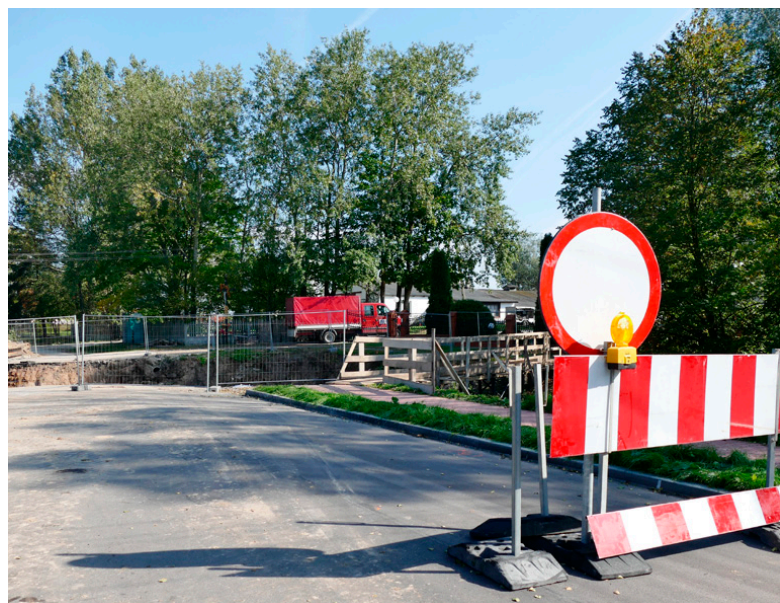
Remont mostu w Porzeczcu potrwa do końca listopada
