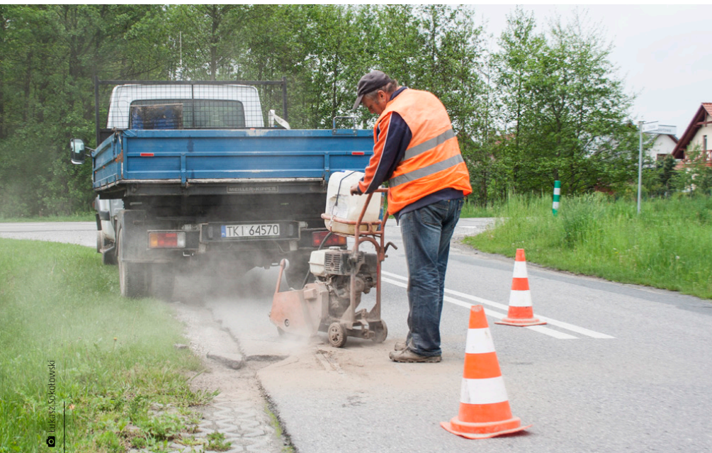
Na drogach gminnych trwają remonty częściowe nawierzchni. Ekipę drogowców można było spotkać m.in. na ulicy Strażackiej w Ćmińsku czy Dworskiej w Kostomłotach Drugich
