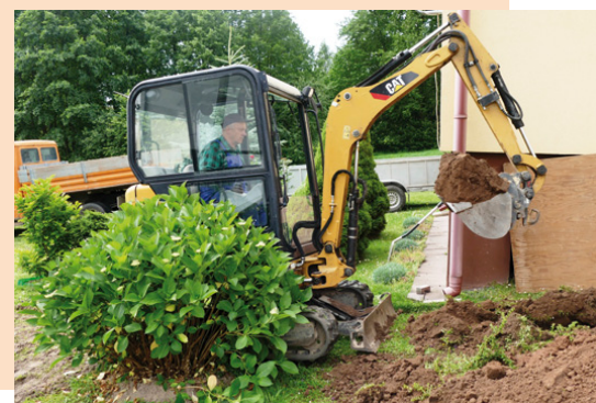
Nowy sprzęt już pracuje na terenie gminy
