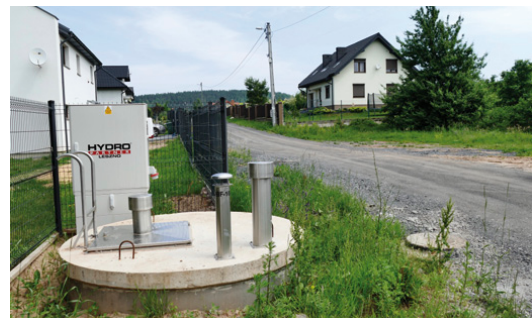
Pompownia ścieków przy ul. Cichej w Ciosowej w gminie Miedziana Góra - ETAP IV oraz rozbudowa oczyszczalni ścieków w Kostomłotach Drugich - Etap II" z Regionalnego Programu Operacyjnego Województwa Świętokrzyskiego na lata 2014-2020. ■ (nieb.)
