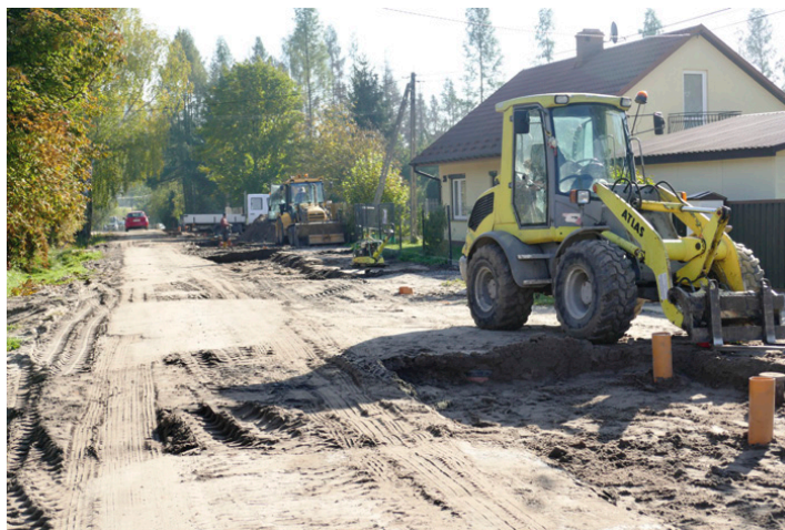
Ruszyły prace przy modernizacji ul. Wyrowce
